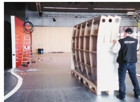
104 Wandelemente warteten sorgfältig verpackt rund um die Halle auf ihren Aufbau. Rund 2,8 Meter hoch und 2 Meter breit war ein Element und brachte rund 90 Kilogramm auf die Waage.
